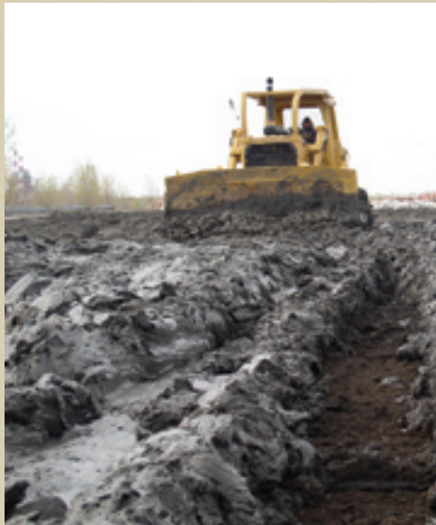
BULLDOZING WET SEDIMENT
